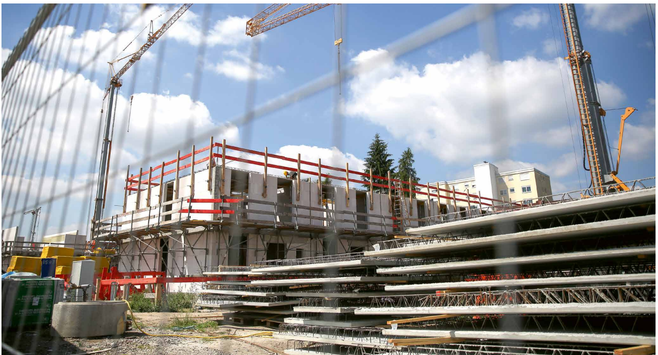
Bauarbeiter auf einer Baustelle im Rhein-Main-Gebiet.
