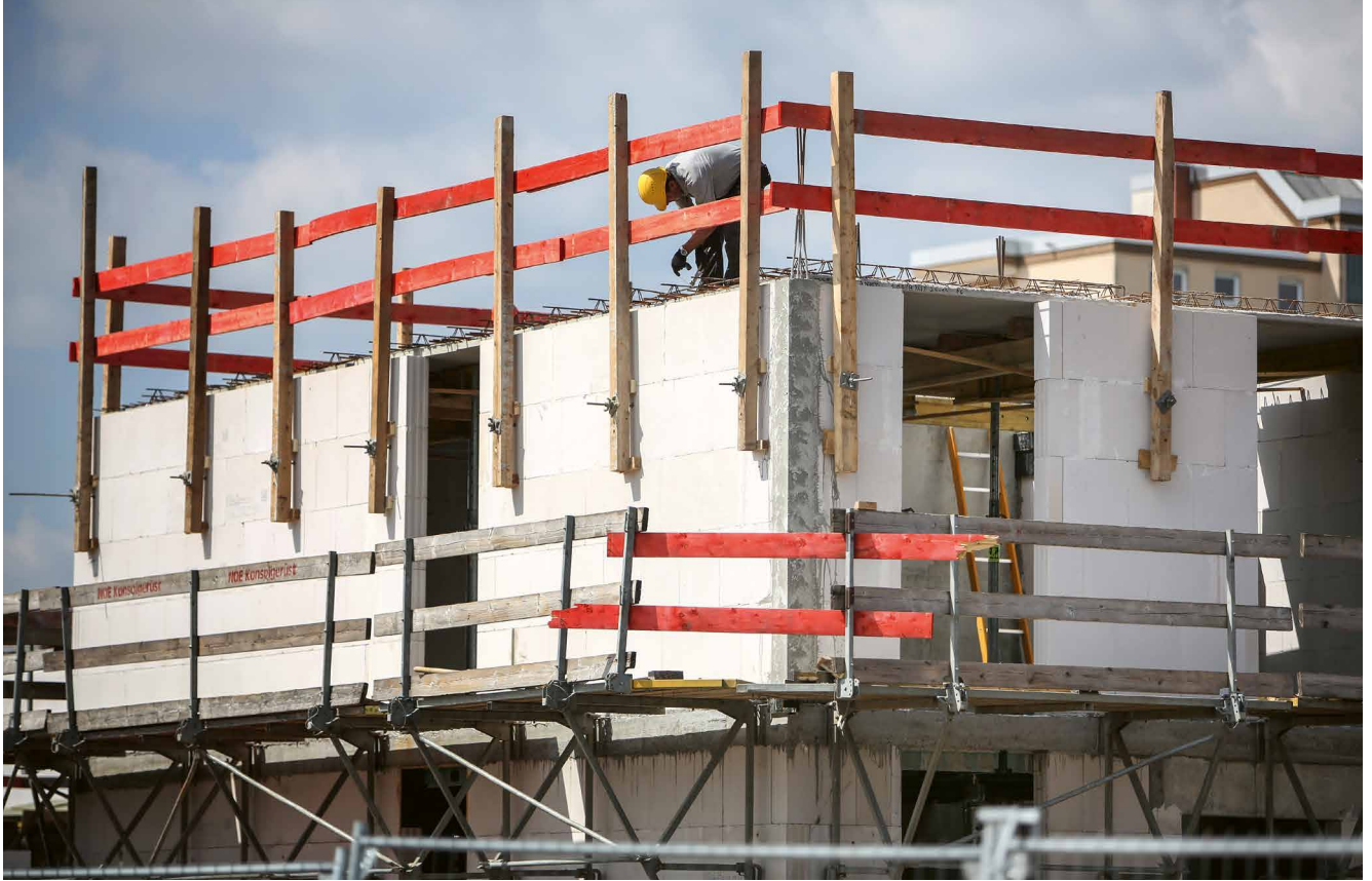
Bauarbeiter flechtet Eisen auf einer Baustelle in Frankfurt am Main.
